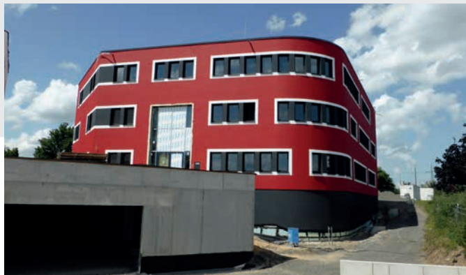
Der Neubau leuchtet bereits in Hinz-Rot. Nun folgt noch die Installation des Logos.
